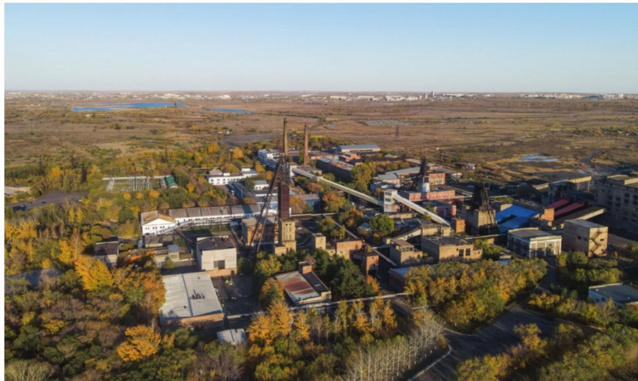
La mine de Kostenko où 46 mineurs ont trouvé la mort le 28 octobre 2023.
